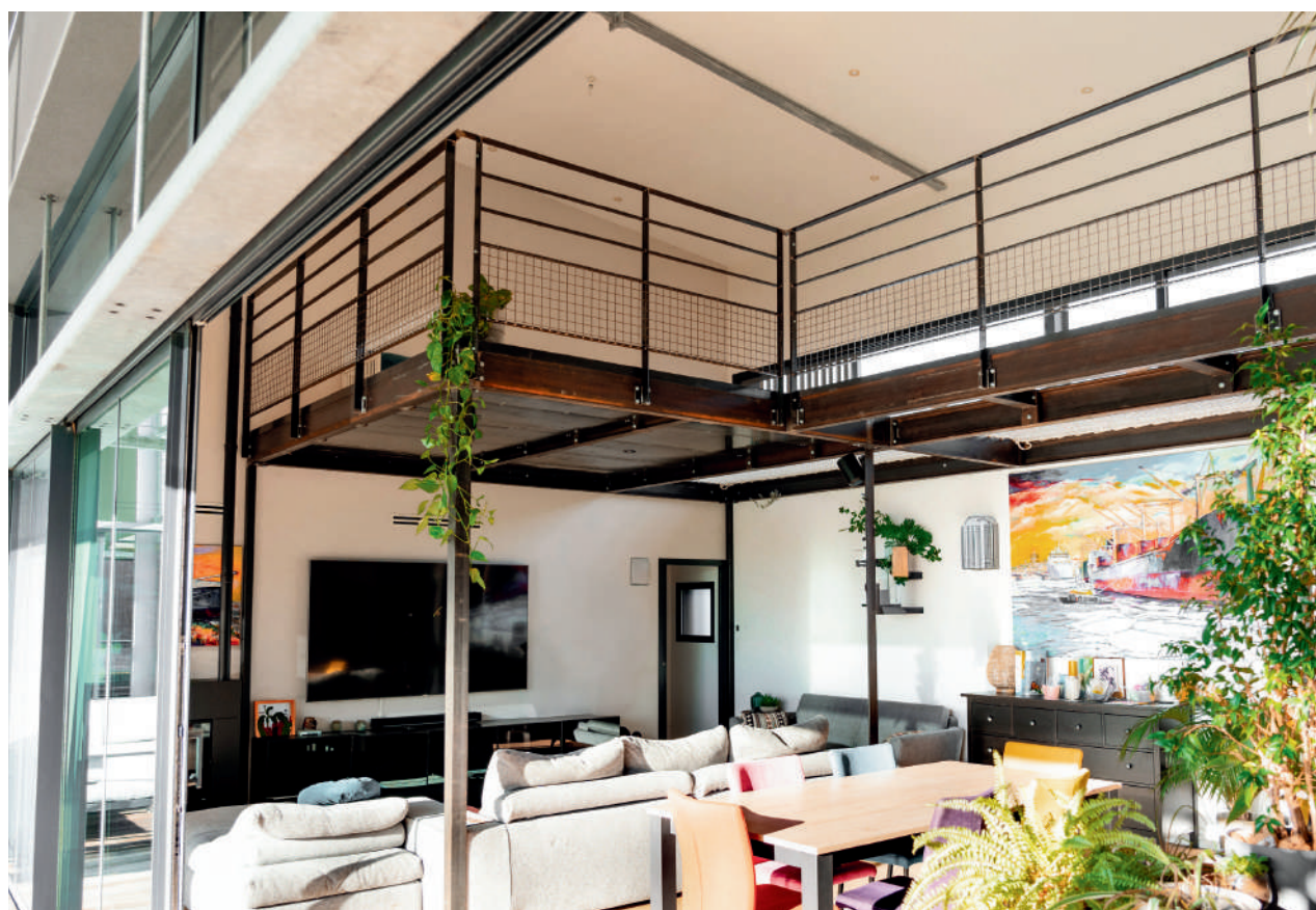
Finition brut huilé + garde-corps lisse intermédiaire + soubassement grillagé
