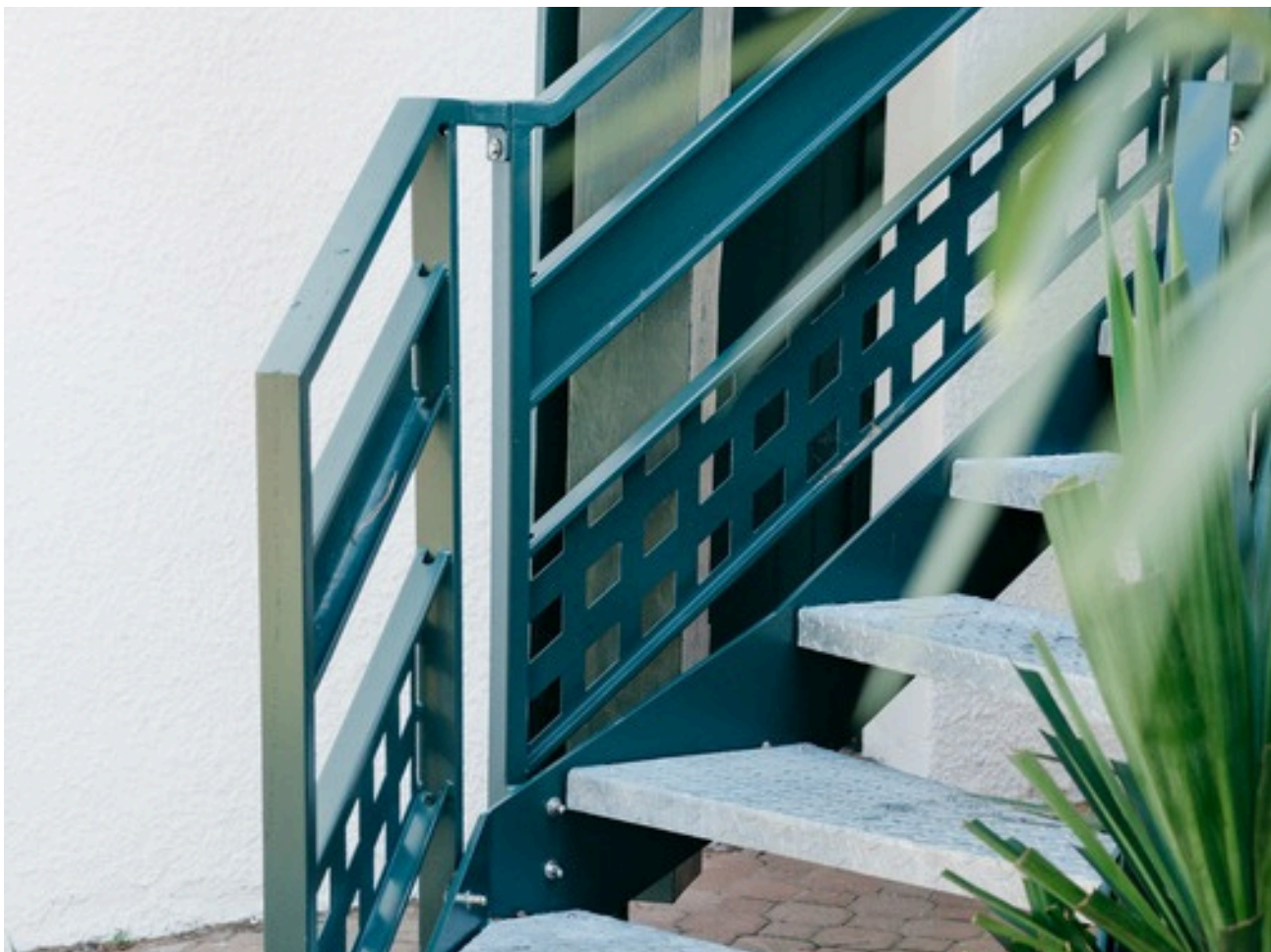
Garde corps en tôle perforée + thermolaquage RAL 6012
