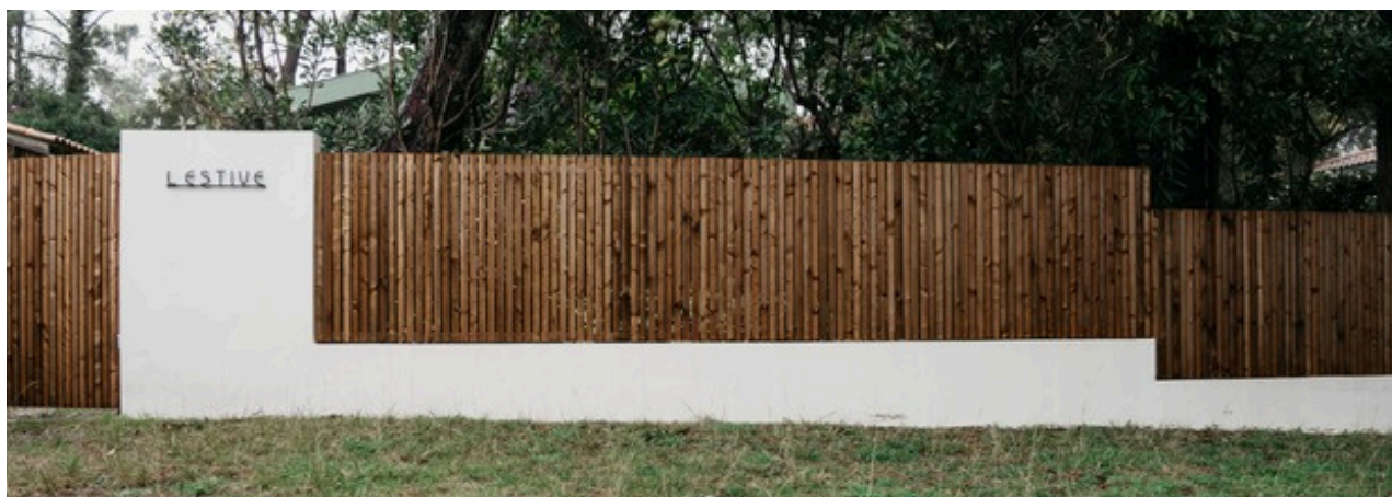
cadre galvanisé à chaud + remplissage liteaux épicéa
