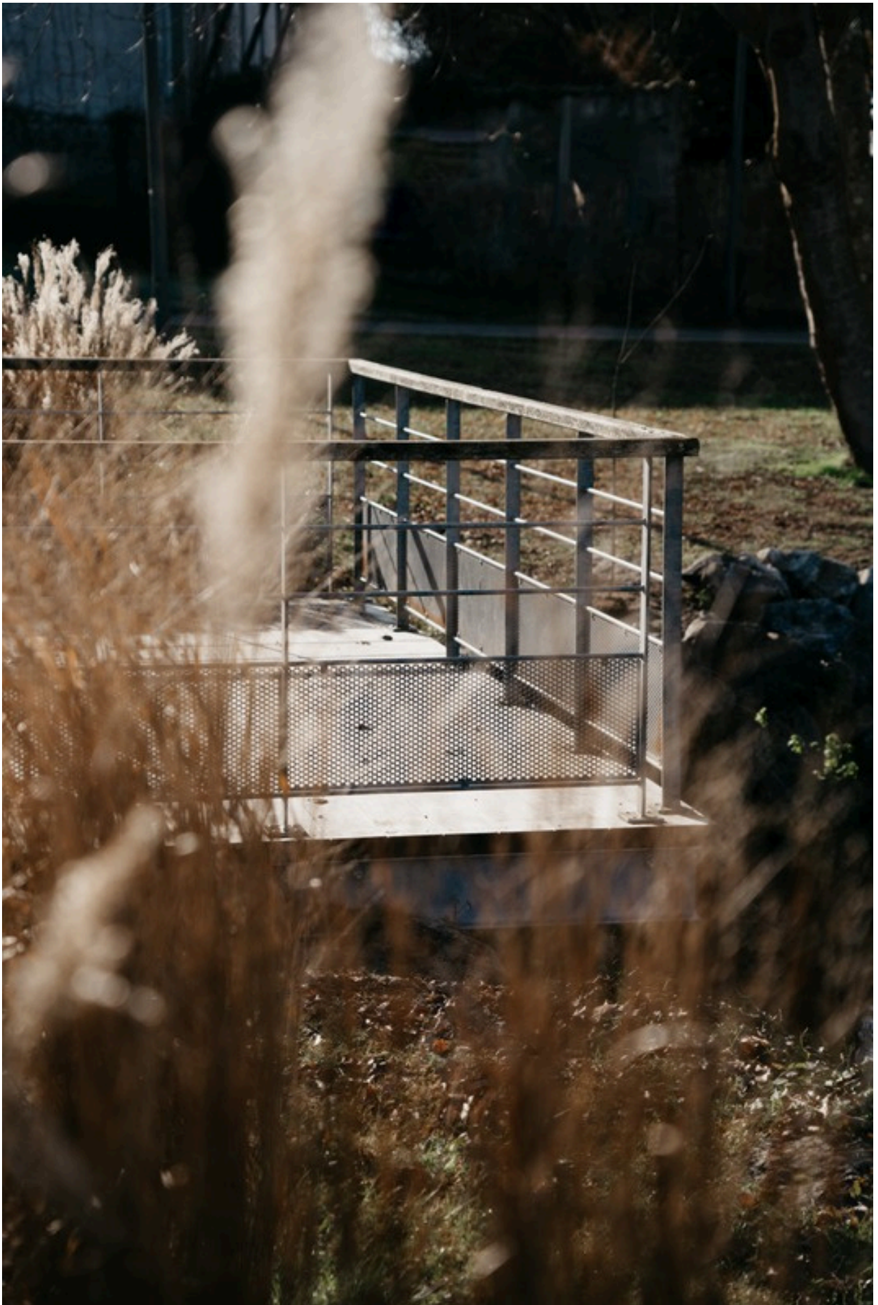
Structure de passerelle , Mairie de Tosse
