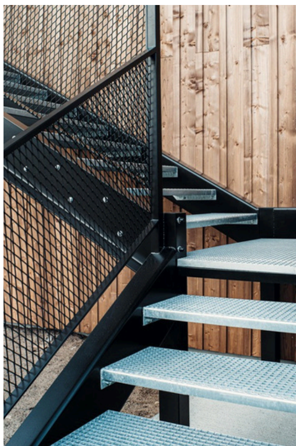
Exemples d'escaliers tournants : double-quart tournant (en haut) et 1/4 tournant (en bas)
