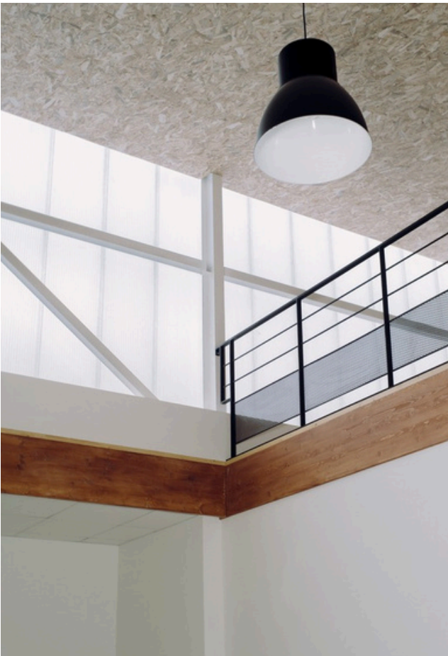
Garde-corps droit soubassement en tôle perforée
